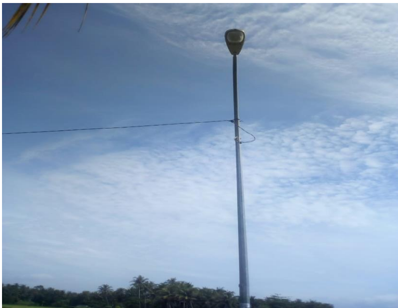
Gambar 1.8 : Pengadaan Lampu Penerangan Jalan Umum (Kalimundu – Pranti)
